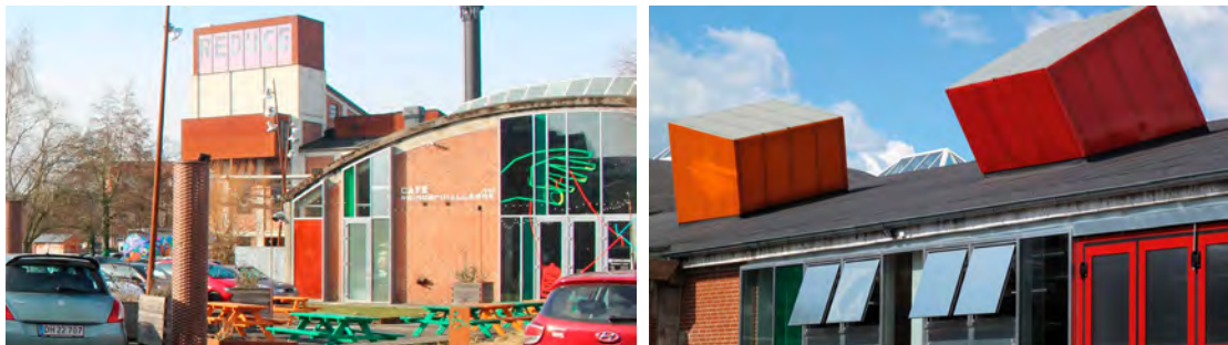
Figur 4 Fotos der viser Spinderihallerne, med mindre røde, grønne og orange bygningsdetaljer.
