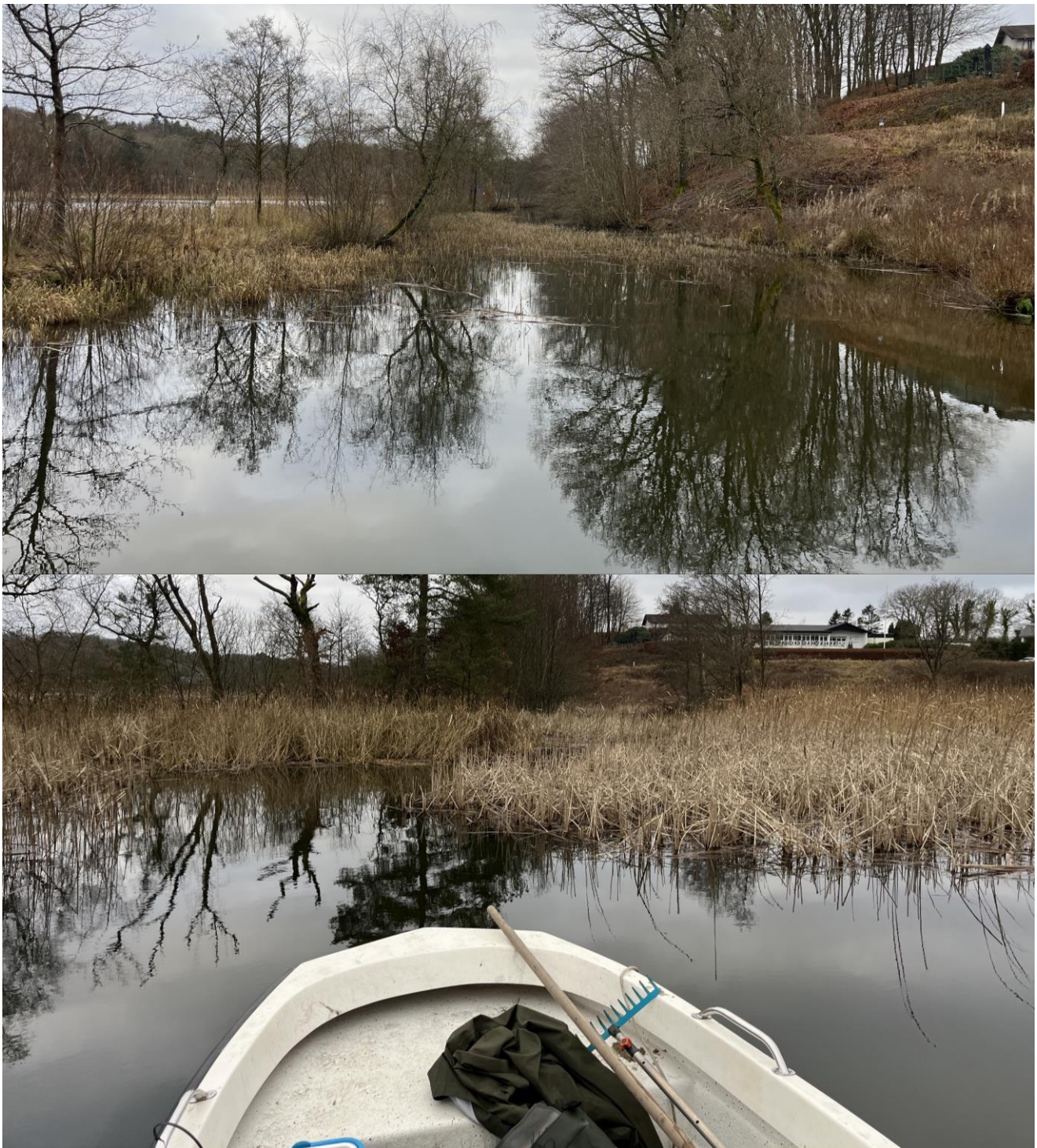
Figur 5.3: Kanalen ved afløbet fra Rørbæk Sø. Som det fremgår, er kanalen tilgroet med tagrør, som bør skæres og fjernes for at sikre sejlbarhed for arbejdspram.
