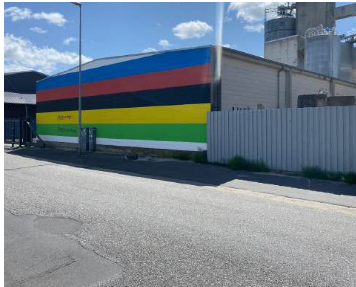
Gavlen modsat kontoret har kunst fra Tour de France 2022.
