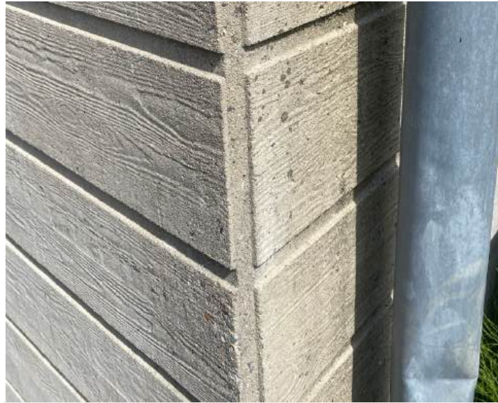
Den nedre del af facaden er blottet med betonelementer der skiller sig ud med synlig træstruktur på overfladen efter støbeforme. Fin afslutning omkring bygningens hjørner.
