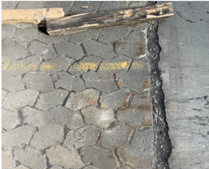
Terrændækket sammenblanding af SF-sten og beton.
