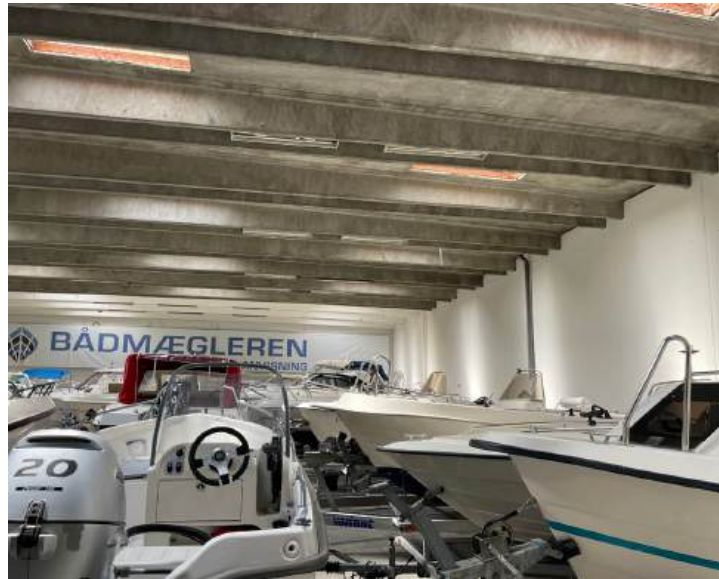
Indvendigt i både værkstedet og den store hal, kan man se synlige beton bjælker som understøttes på ydervæggene. Loftet, gulv og vægge er i beton.
