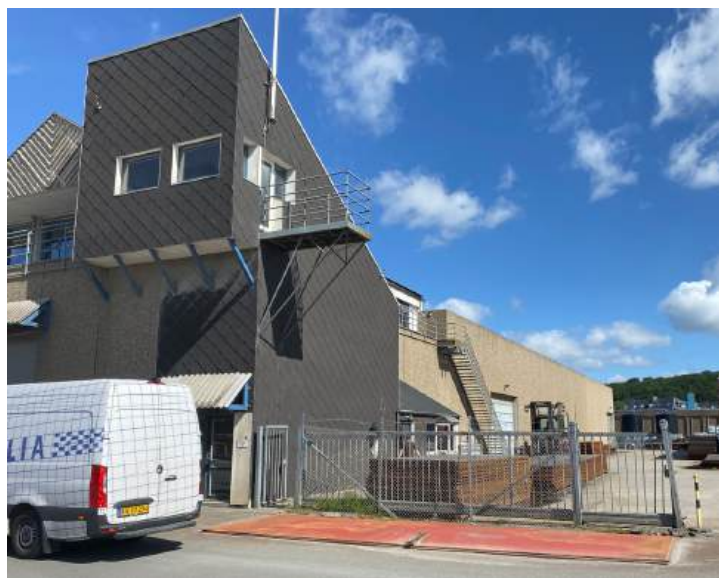
Antal etager: 1-2 etager Rumhøjde i den store hal: 6,4 m Frihøjde portrum: 4,4 m Sammenbygning af 2 lagerhaller og en 1. sal med kontor.
