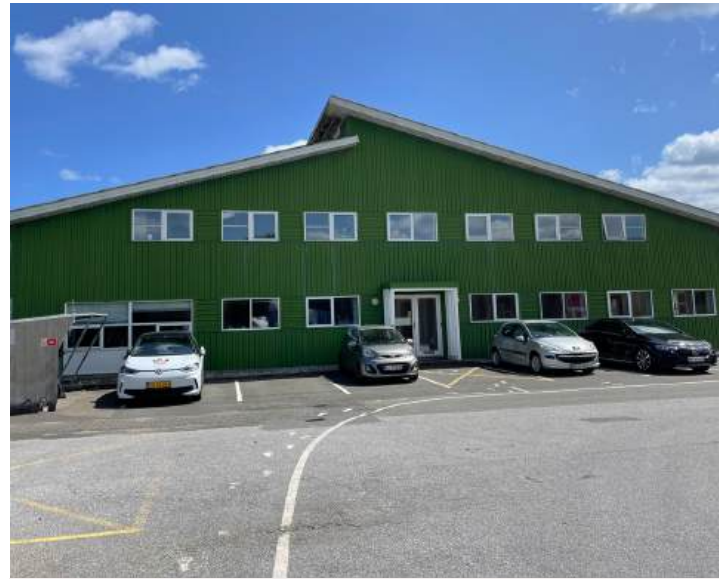
Grønmalet sinusplader skruet fast. Portåbninger i hallen. Hvide plastik vinduer og -døre i kontordel. Taget er udført med bølgeeternit (muligvis med asbest) og hvidmalet sternbrædder.
