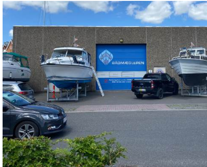
Facaderne er bygget med sandwichelementer med strandsten på beton. Der er ingen åbninger i facaderne ud over enkle porte mod syd. Den store hal er med saddeltag og lav hældning beklædt med tagpap. Begge haller har ovenlys.
