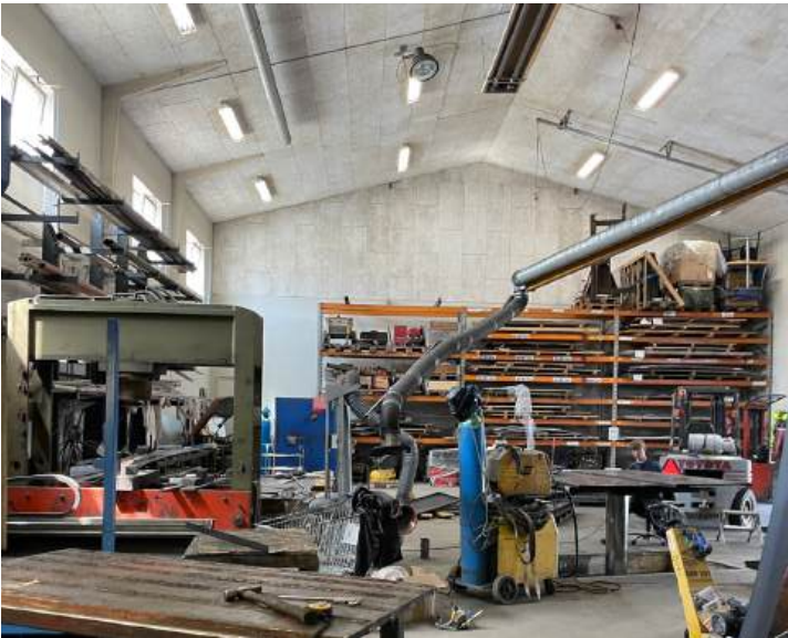
Den store hal fra 2012 fremstår i god stand og med åbninger i den ene facade, som giver dagslys. Hallen er let isoleret og indvendigt beklædt med fibercementplader i loftet og gavl. Der er en enkel port fra gadeside. Delvis synlige stål-konstruktioner med sandwichelementer. Den lille hal fremstår med synlige stålkonstruktioner og let isolering.
