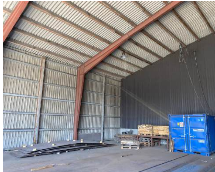
Terrændæk i beton.
