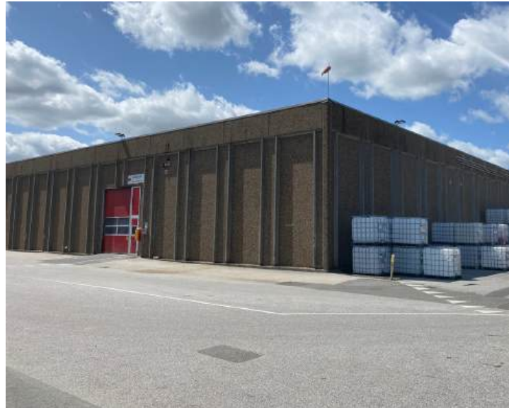
Antal etager: 1 Rumhøjder: Ukendt En rektangulær bygning sammenbygget med et halvt tag til den tilstødende hal.
