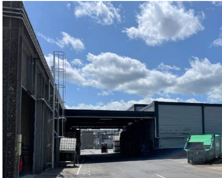
Et stort samlende halvtag er spændt ud mellem lagerhal 11 og 12.
