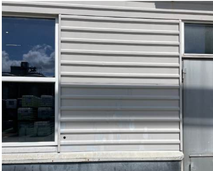
Stålelement facade. Indvendig synlig stål konstruktion. Ingen dagslys. Saddeltag med lav hældning og formentlig beklædt med tagpap. Taget brydes af et gennemløbende ovenlys.
