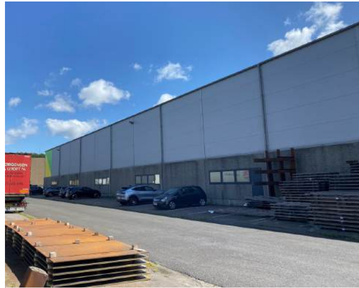
Nedre del af facaden er søsten-betonelementer. Den vestvendte facade med vinduer, og øvrige facader lukket. Sydvendt gavl med stor port. Facadens øvre del er sandwichelementer med limet stålplader. Sadeltag med lav hældning og uden ovenlys. Formentlig med tagpap.
