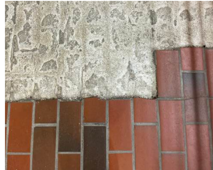
Flisegulv i stueetagen med betondæk som undergulv. 1 sal ukendt.
