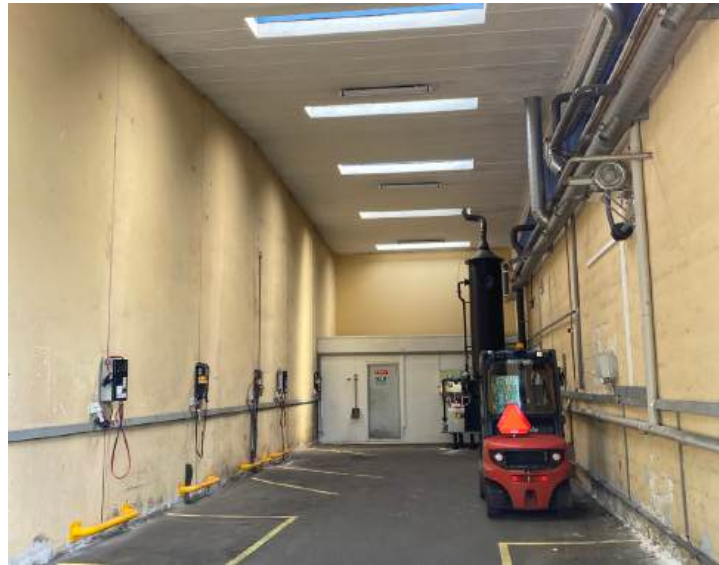
Hallen kunne ikke besørges indvendigt, men portrummet her repræsentere formentlig hallens opbygningen. Betonelementer af vægge og tag samt store rum med en høj frihøjde.
