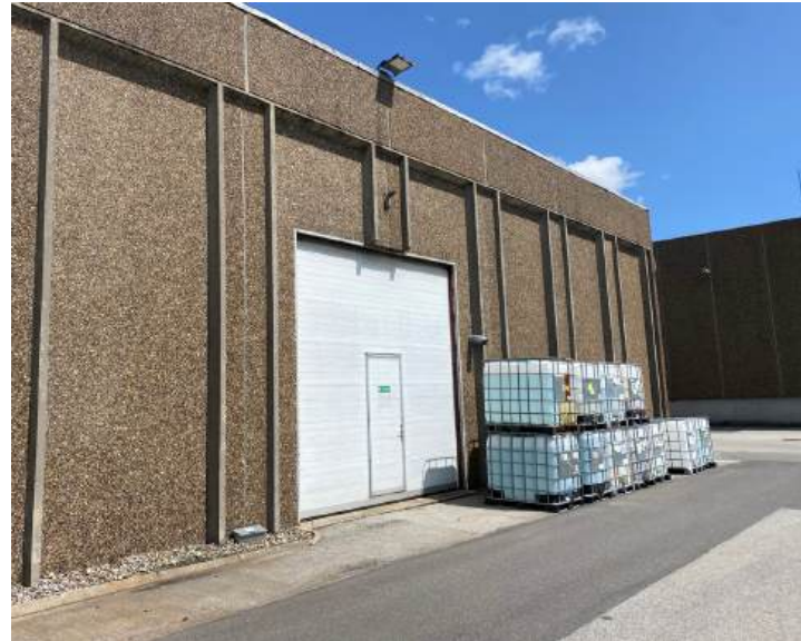
Bygningen er generelt meget stor og mængden af beton ved en nedrivning må forventes at være omfattende og svært at genbruge de enkle betonelementer.
