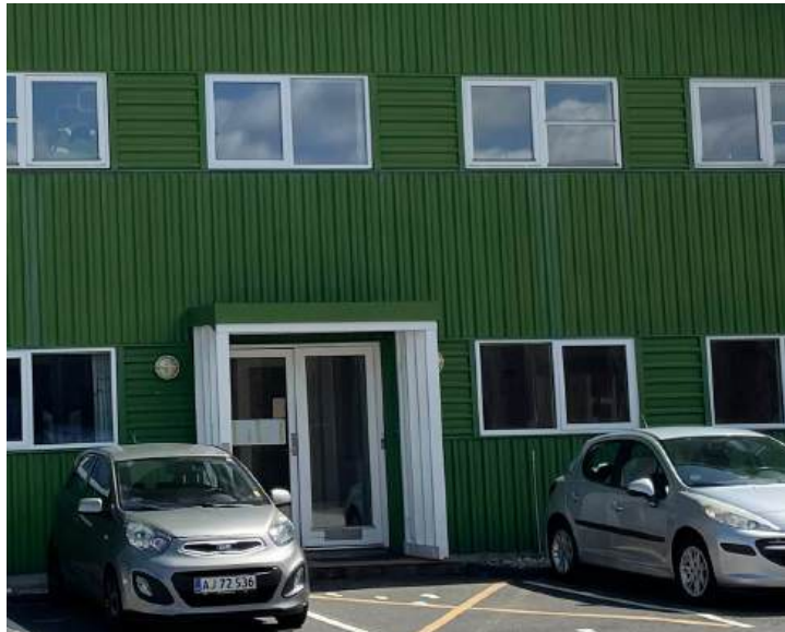
Bygningen har ikke været mulig at besigtige indefra i forbindelse med denne registrering. Formentlig indvendig stålkonstruktion.
