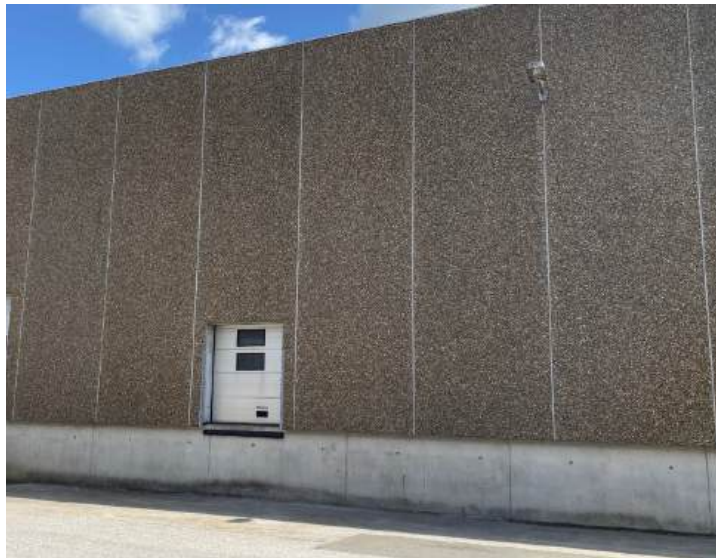
Facaderne er alle bygget med søsten-betonelementer. Der er kun enkle åbninger i facaden.
