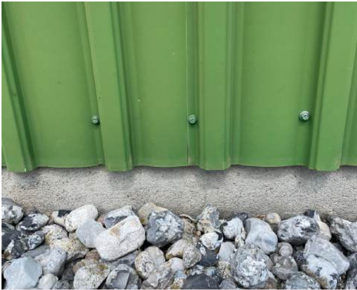
Betonsokkel fremstår i god stand.
