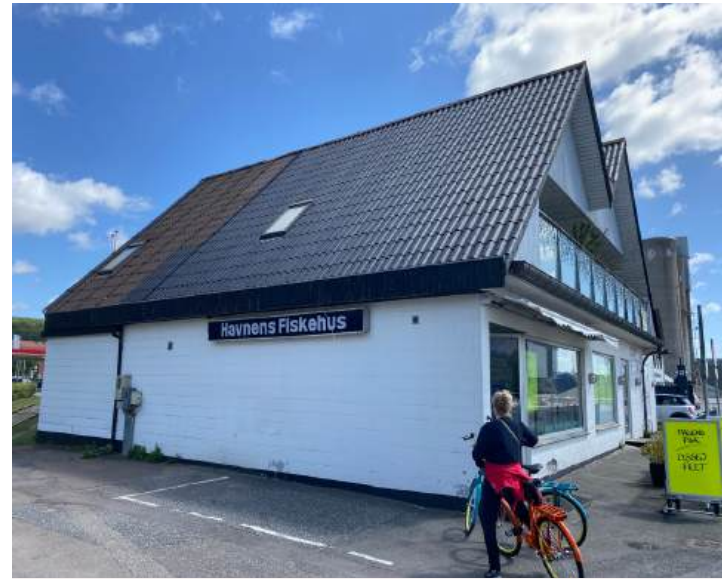
Stueetage: Hvidmalet gasbeton blokke 1 sal beklædt med malet træ i gavlen. Saddeltag med bølgeeternit kan skrues af Sternbrædder malet.
