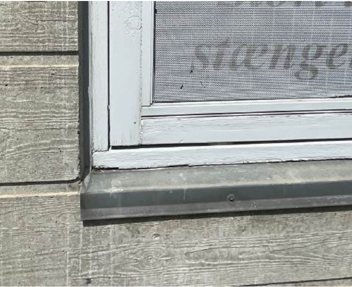
Vinduer i hvidmalet træ og fint foldet sålbænk i stål.
