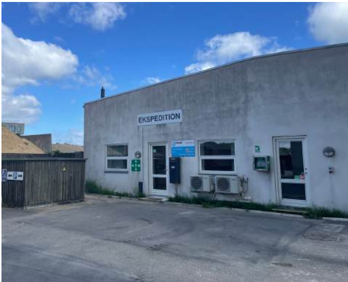
Kontor i den ene ende af bygningen. Bemærk der er en transformestation placeret ved siden af.
