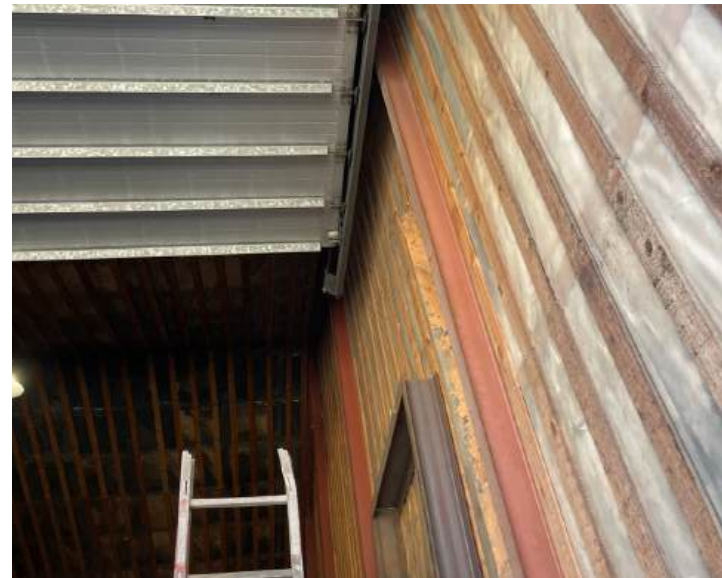
Indvendig væg med skruet sinusplade samt isolering monteret med brædder i den isolerede hal.
