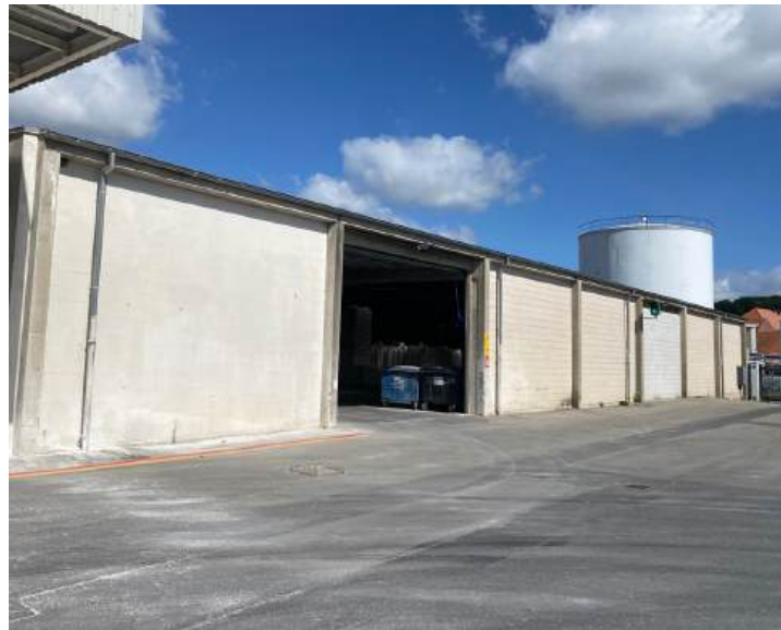
Antal etager: 1 Rumhøjder hal: 4,3 - 4,8 m Port indgange: 2,3 m Aflang hal med integreret kontor i den ene ende og en silo nær gavlen som er koblet op de øvrige siloer.
