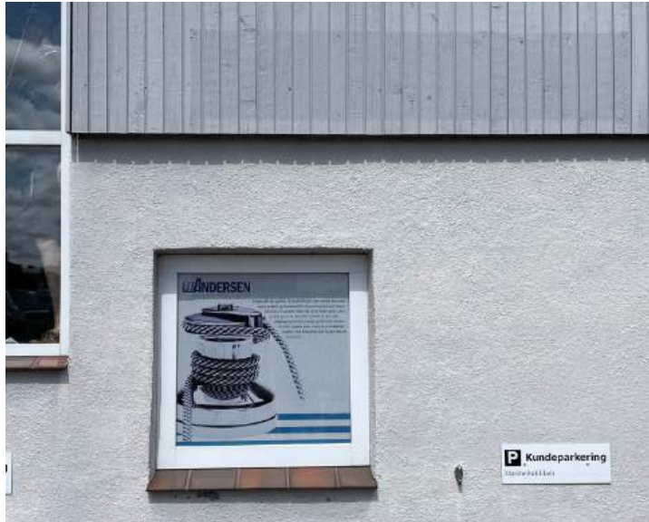
Pudset facader delvis beklædt med grå malet træ. Hvide vinduer og døre i plastik og flere steder flotte sålbænke i tegl.
