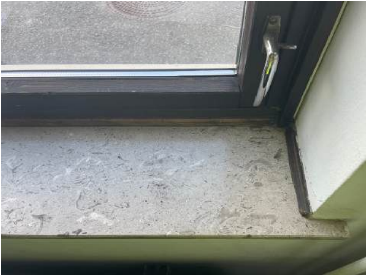
Vindueskarme i marmor stueetagen. 1. sal uden vinduesplader.
