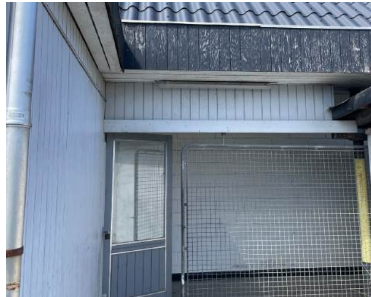
Sammenbygninger og generel bygnings tilstand.
