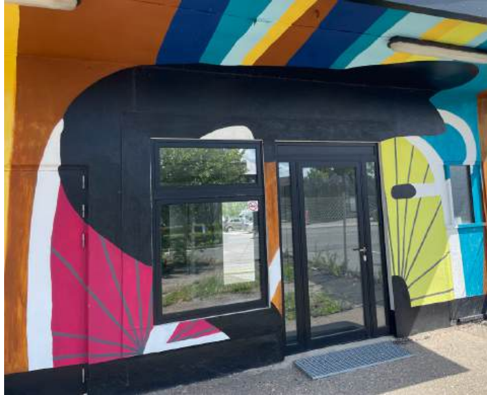
Facader i malet beton. Tydelig markering af indgangen. Vinduer og porte i træ.
