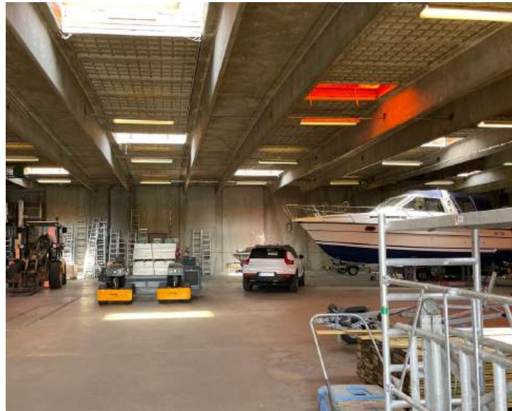
Indvendigt rå betonelementer på vægge og lofter. Synlige betonbjælker der hviler af på ydervæggene. Indvendigt fremstår betonen generelt i god stand.
