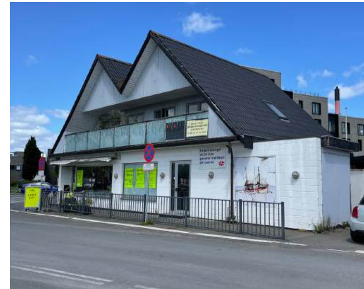
Antal etager: 1-2 Rumhøjde i butik: ca. 2,9 m 2 etager og mange tilbygninger. Adgang til butik fra stueetagen.
