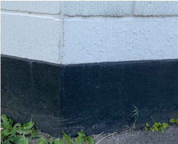
Sort malet beton sokkel.
