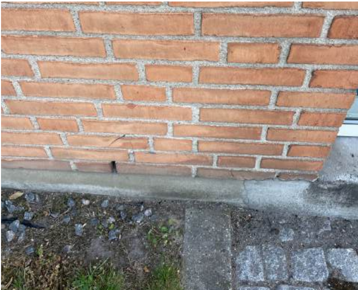
Betonsokkel i overordnet god stand.
