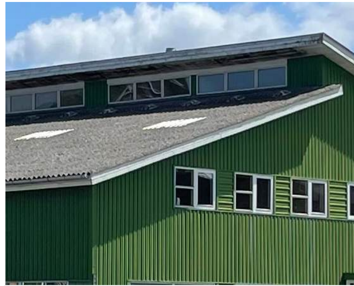
Taget er inddelt i to forskudte flader med ensidigt fald hvori der er monteret et vinduesbånd. Der er også ovenlys jævnt fordelt i den øvrige del af tagfladerne.
