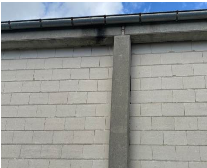
Facaderne består af (delvis) malet gasbeton blokke med synlige beton konstruktioner. Gavlene er pudset beton. I kontoret er der døre og vinduer men ellers blot ovenlys i taget og enkle portåbninger. Hallen er udført med saddeltag med lav hældning og ovenlys. Taget er beklædt med tagpap og vurderes til at være slidt men tæt.
