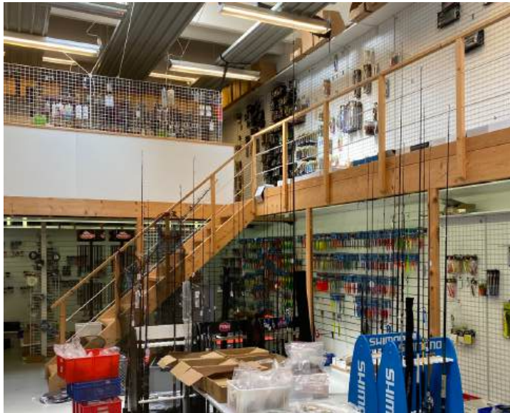
Indvendigt rå beton vægge. God stand Indvendig synlige stål konstruktioner. God stand. Integreret kran.
