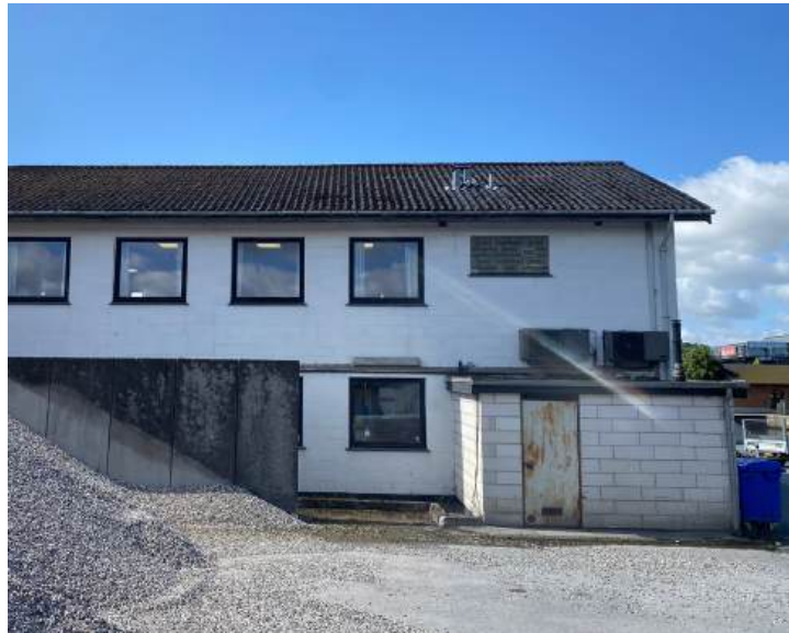
Hvidmalet gasbeton blokke og sort malet trævinduer. Saddeltag med bølgeeternit (slidt) Sternbrædder malet.
