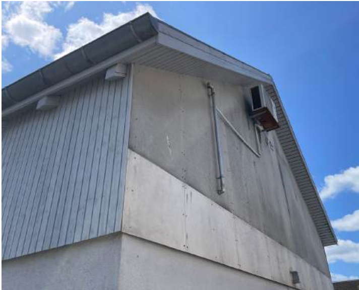
Formentligt originalt da stålsøjler passer til denne forskydning og er boltet fast i betonen.
