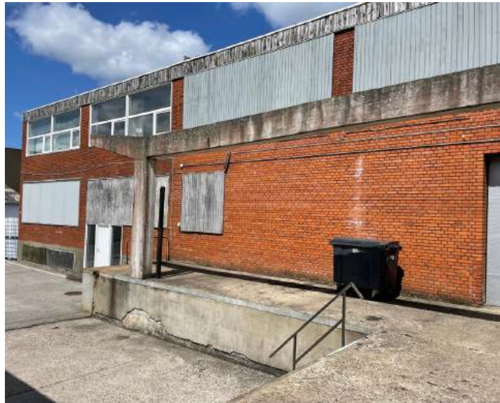
Røde mursten der smukt er patineret. Formentlig fuldmuret. Udformet efter funktion og har dagslys i kontordelen. Produktionshallen er helt uden åbninger med undtagelse af enkle porte. Fin detaljeret (men slidt) murkrone beklædt med træ på facaden. Saddeltag med lav hældning og tagpap.
