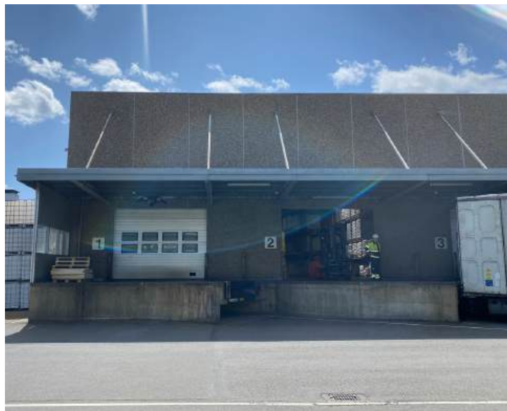
Der er et integreret repos med halvtag for vareudlevering og hvor lastbiler kan læses direkte fra hallen.
