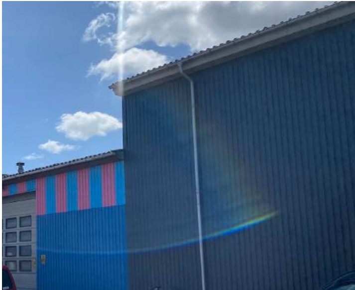
Sandwichelementer beklædt med malet sinuesplader der er skuret fast. Bygningerne er udvalgte steder med vinduer hvor dagslys er udmærket. Saddeltage med fibercement og stål. Den lille hal har ovenlys.
