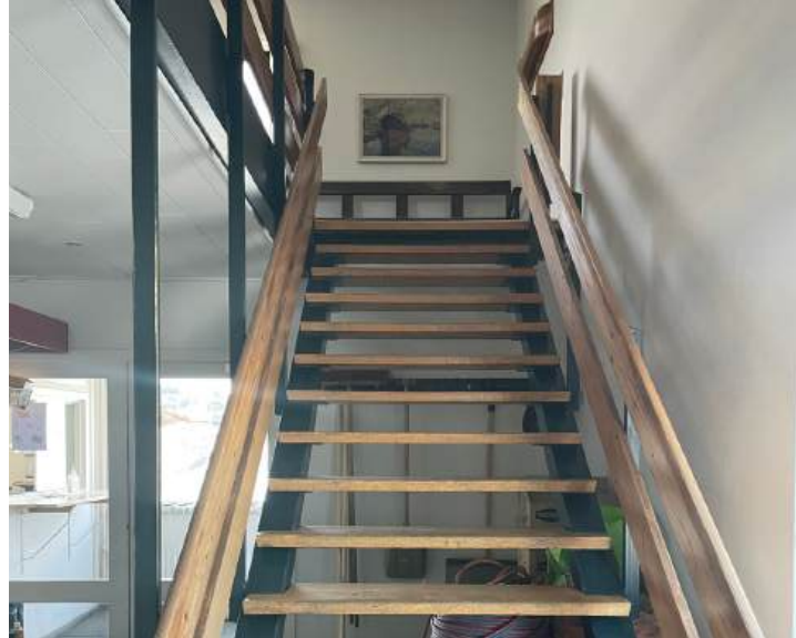
I indgangen findes en stålkonstrueret trappe med trin og værn i træ.
