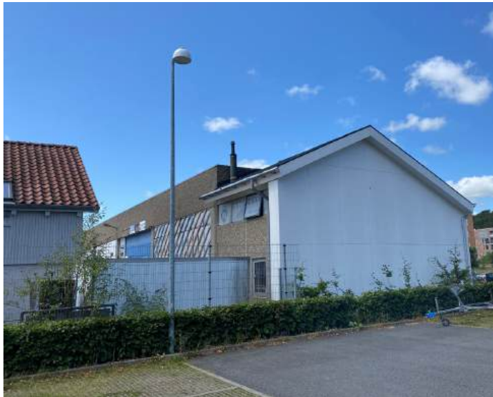
Butikken er ikke registreret indvendigt. Bygning er placeret tæt op en værkstedshal for både.
