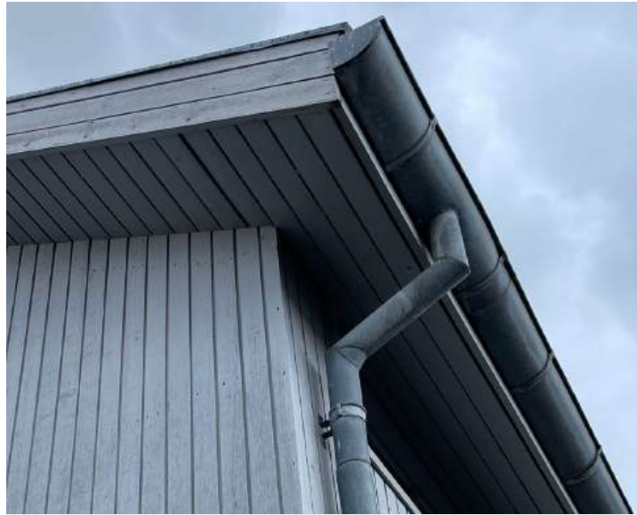
Tagudhæng, sternbrædder og øvre del af facaden er beklædt med grå malet træ.
