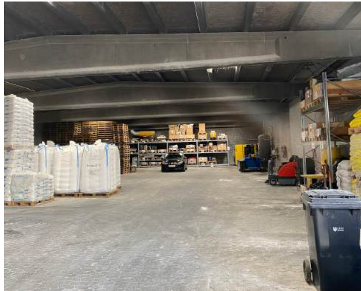
Hallen har synlige bærende beton-konstruktioner, der i sin helhed fremstår i en flot takt gennem hele hallen, og de vurderes til at være i god stand. Dagslys og udsyn er sparsomt. Hallen er uisolaret mens kontoret er isoleret.
