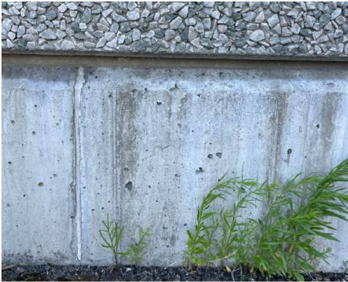
Betonsokkel i udmærket stand.
