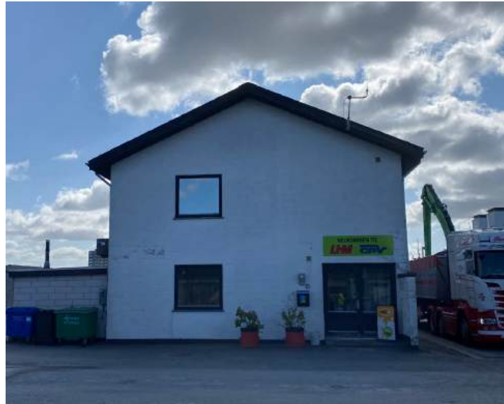
Antal etager: 2 med en enkel mindre tilbygning. Rumhøjde stueetage: 2,6 m Rumhøjde 1. sal: 2,6 m
