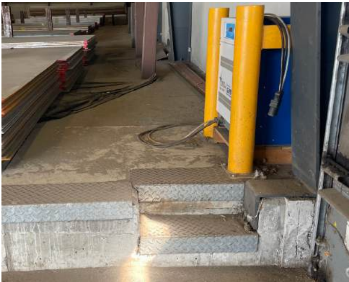
Bemærk terrændæk i to niveauer. Det antages det er originalt da stålsøjler passer til denne forskydning og er boltet fast i betonen.
