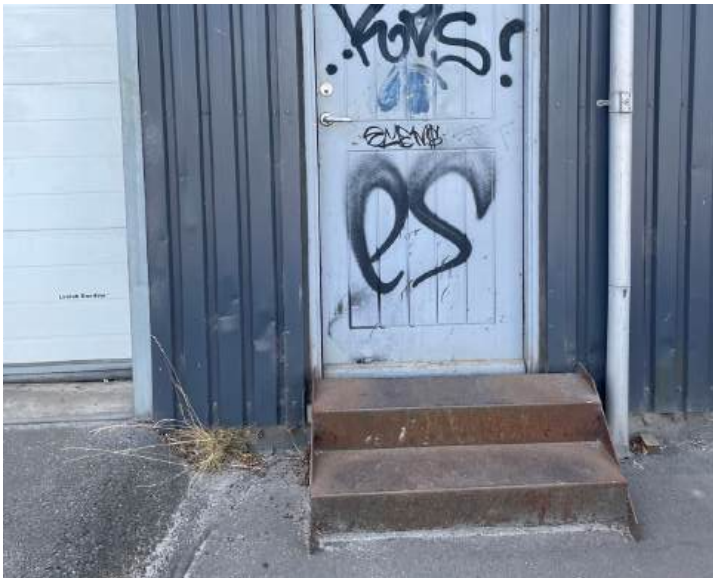
Fin lille udvendig ståltrappe. Generelt mange små detaljer der giver stedet identitet og sjæl.
