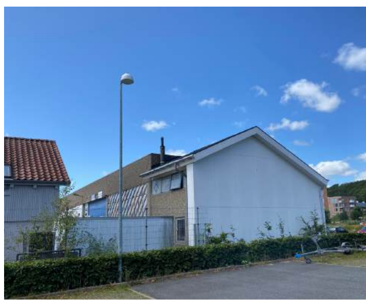
Antal etager: 1-2 Rumhøjde: ca. 7 m To rektangulære haller der er sammenbygget og med en lystfiskerbutik indbygget i den ene hal.
