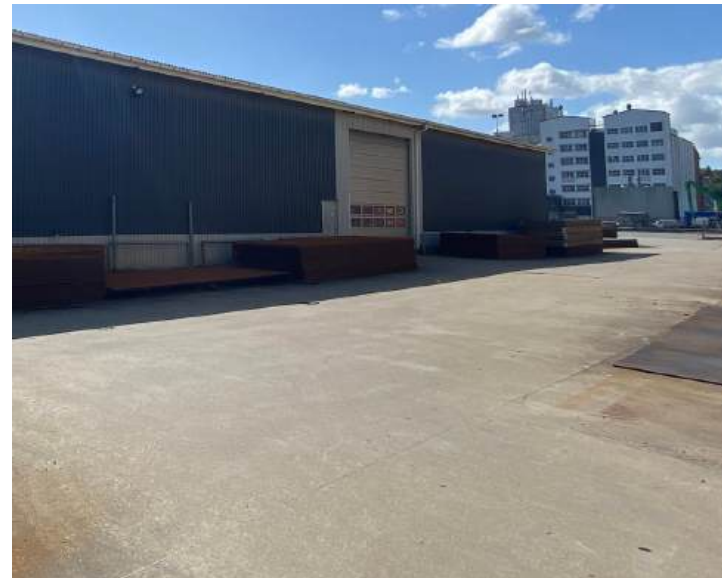
Enkle portåbninger og ellers ingen mulighed for dagslys. Omkring hallens ses de store stålplader alle vegne.
