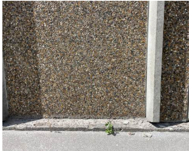
Facaderne består af søsten-betonelementer med synlige udvendige beton elementer. Enkle port- og døråbninger, men ellers fremstår hallen meget lukket. Taget med lav taghældning og formentlig beklædt med tagpap. I taget er der monteret en del ovenlys.
