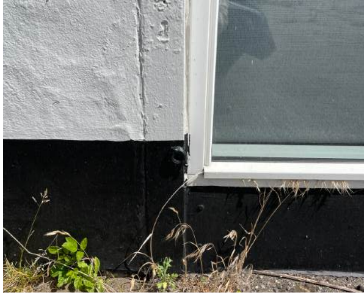
Malet betonsokkel.
