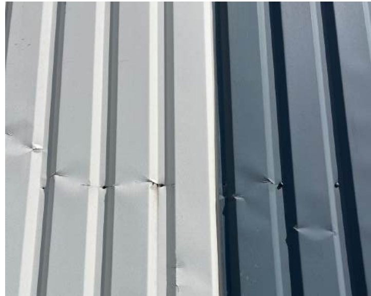
Malet sinusplader i stål som er skruet fast i træ. Dårlig stand og nemme at afmontere. Portåbninger og uden vinduer. Ingen dagslys. Saddeltag med sinusplader.
