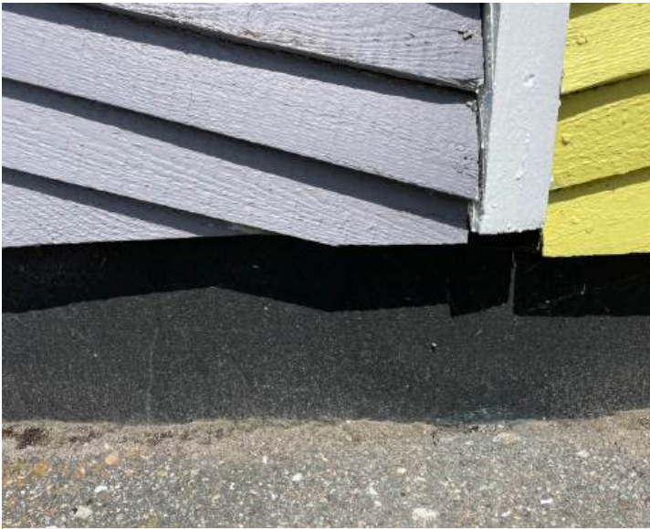
Malet betonsokkel.
