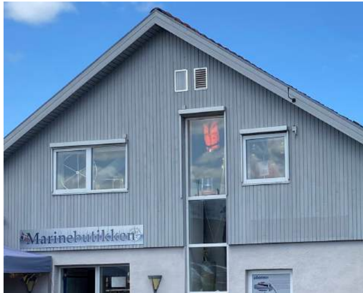
Facaderne er opbygget af letbeton og efterfølgende pudset og malet. 1. salen og den mindre tilbygning er beklædt med grå malet træ. Gavlen på huset bagside er beklædt med fibercementplader (skruet fast). Hvide plastikvinduer. Fint med dagslys. Sadeltag med rødt tegl og enkle tagvinduer.
