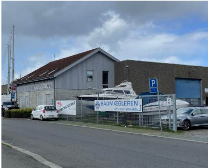
Antal etager: 2 Rumhøjde: ca. 2,5 m Bygning med saddeltag i 2 etager der er sammenbygget med den store hal til opbevaring af både.
