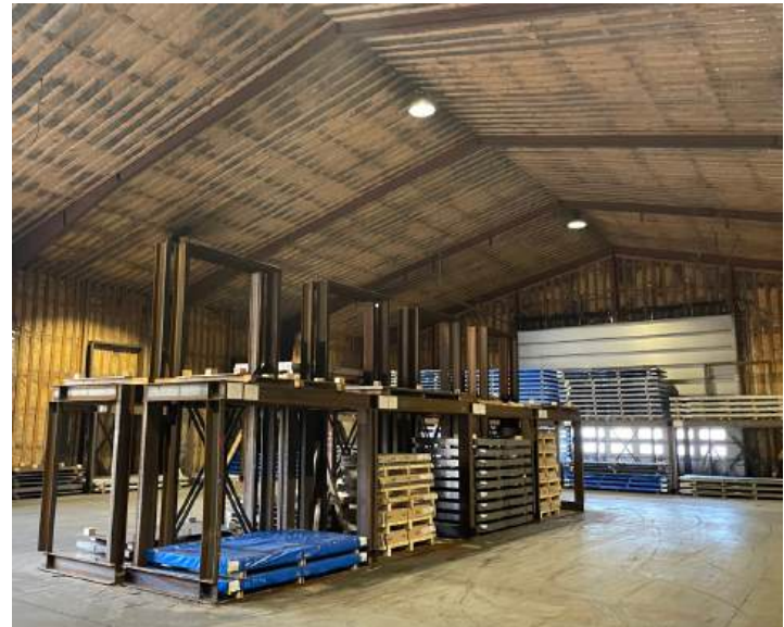
Den anden hal i let isoleret med opbygget på samme måde som den hal den er sammenbygget med; dvs. synlige stål konstruktioner, betondæk og fastskruet sinusplader.
