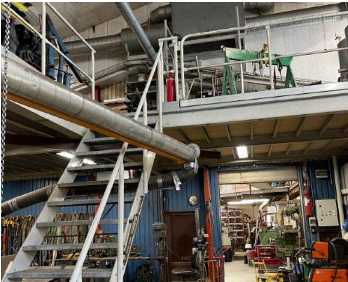
De to haller er sammenbygget.
