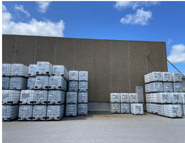
Det har ikke været muligt at besigtige hallen indefra.
