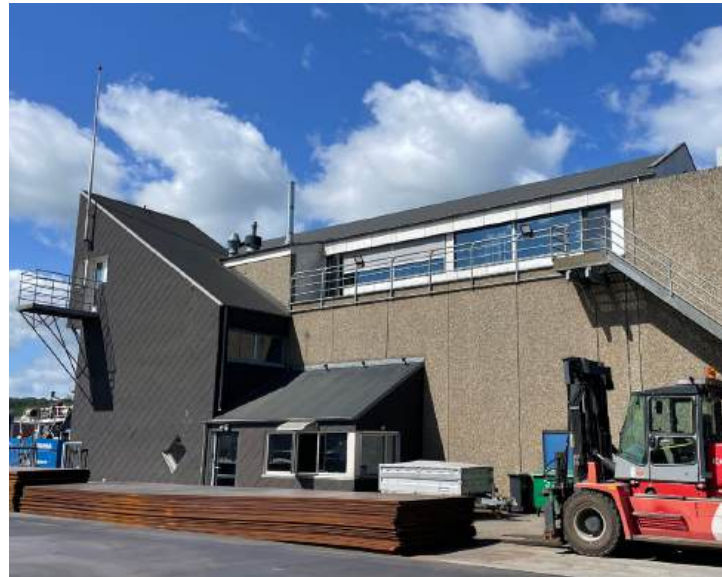
Lagerhallen er opført med søsten-betonelementer med enkle portåbninger og døre. Kontoret fremstår i sin egen arkitektonisk stil som et "Add on", og facaderne er beklædt med skifer. Der er generelt mange finurlige detaljer og det arkitekturen fremstår uklar.
