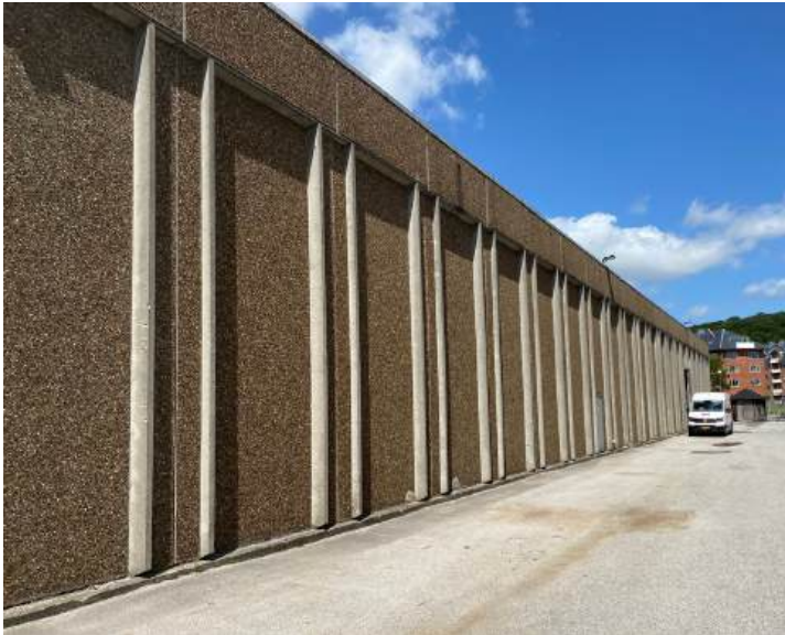
Typetypisk industrihal i beton men med fin detaljering og takt som gør den særlig fra de øvrige lagerhaller i området. Bygnings facader fremstår ens på alle sider, og brydes blot at enkle åbninger.
