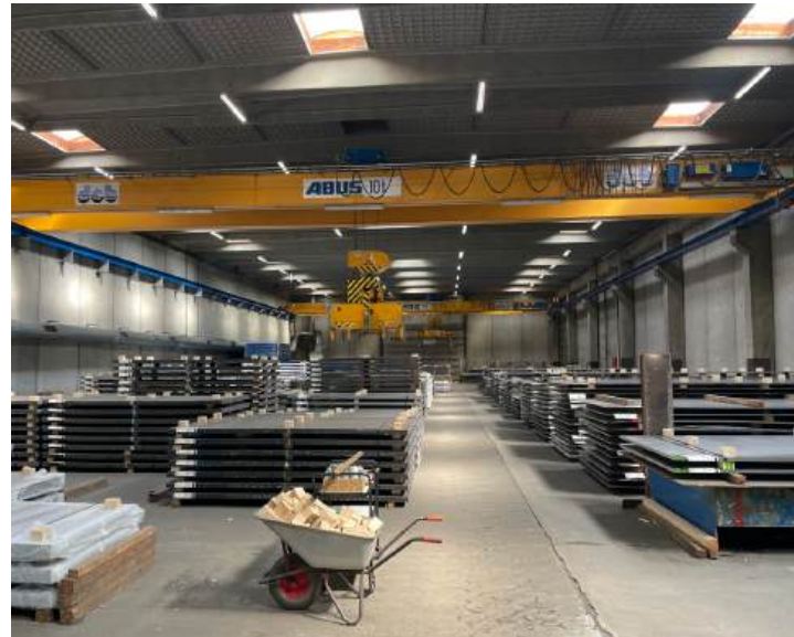
Indvendigt synlig konstruktion i beton og sandwichelementer. Fremstår i god stand. Loftet er udført med betonelementer. En stor integreret kran er indbygget i den store hal.
