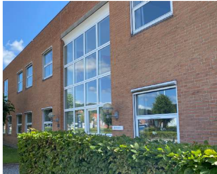
Facaderne er muret med rød/orange sten, lysegrå fuger og hvide vinduer og døre i plastik. Taget er fladt og beklædt med tagpap. Taget brydes af et gennemløbende rytterlys.
