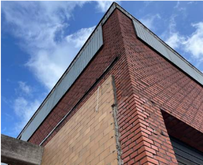
Produktionshallen er uden vinduer og ovenlys. Den har kun portåbninger.
