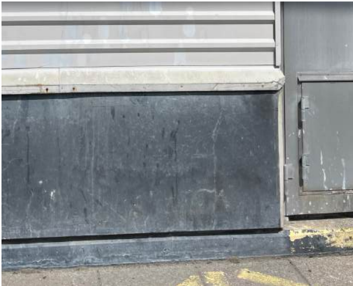
Høj malet, betonsokkel.
