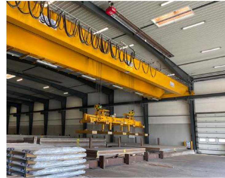
Indvendigt rå beton vægge og loftplader som trapezplader eller et lignende materiale. Indvendig synlige stål konstruktioner der vurderes til at være i rigtig god stand. Integreret kran. Dagslyset er sparsomt.
