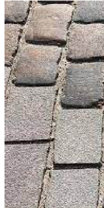
Jetbrændte brosten, komfortsten, flettet med slidte brugte brosten
