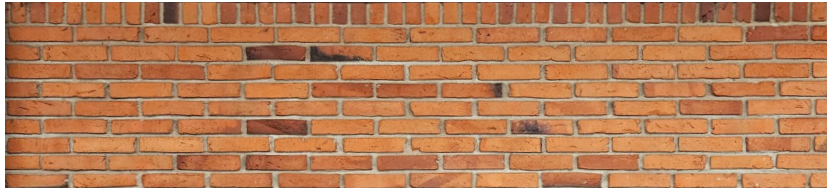
Figur 3. Teglstensfacade på den eksisterende bebyggelse
