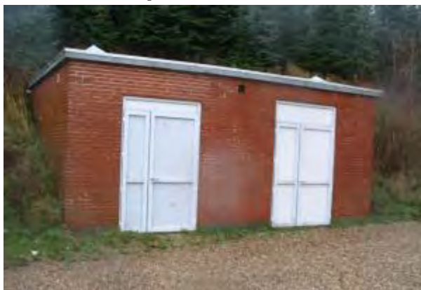
Nr. Vilstrup Vandværk
