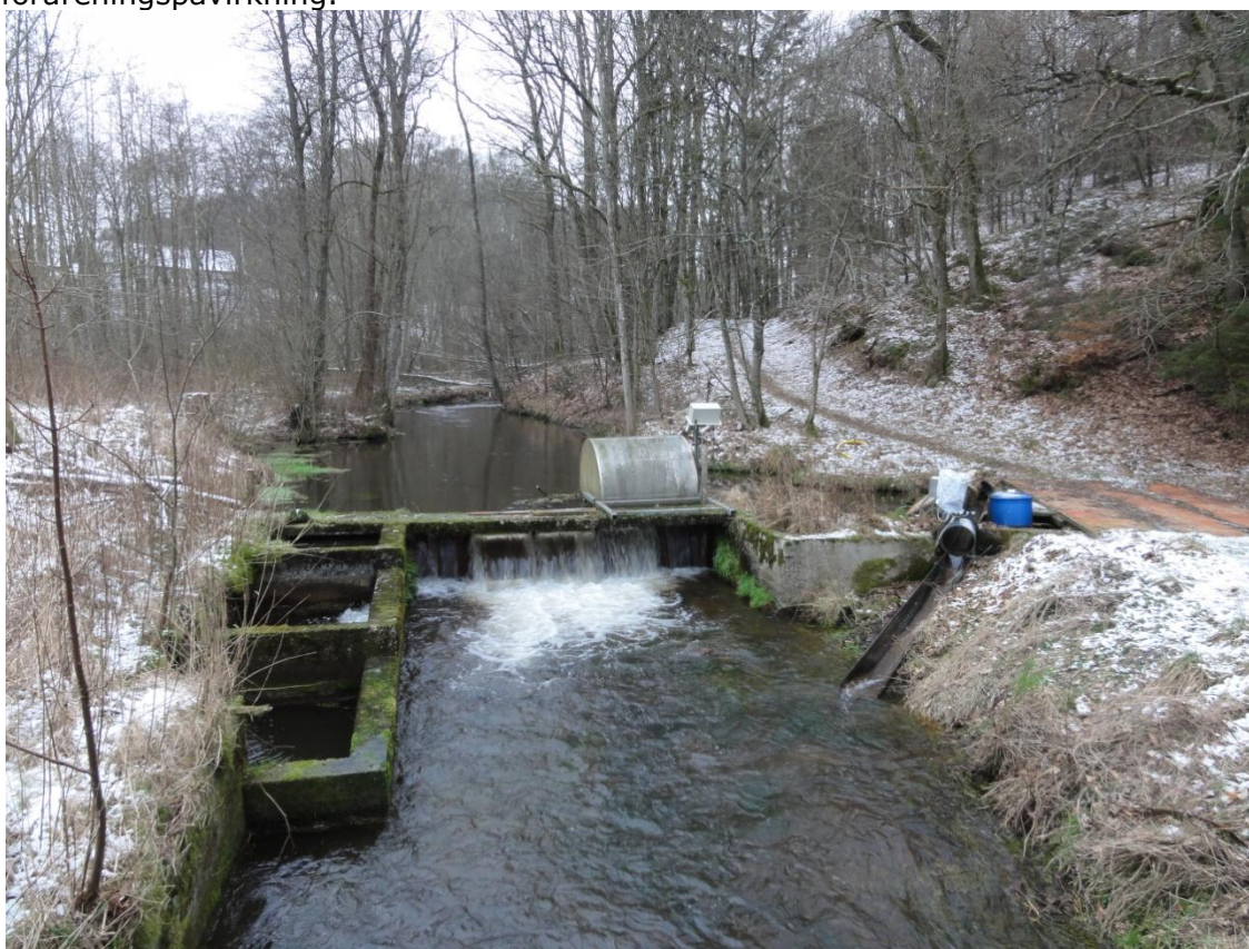
Foto 3 Vejle Å. Stemmeværket ved St. Lihme fiskeri. Bundet opstrøms stemmeværket sandbund og opstuvning.
