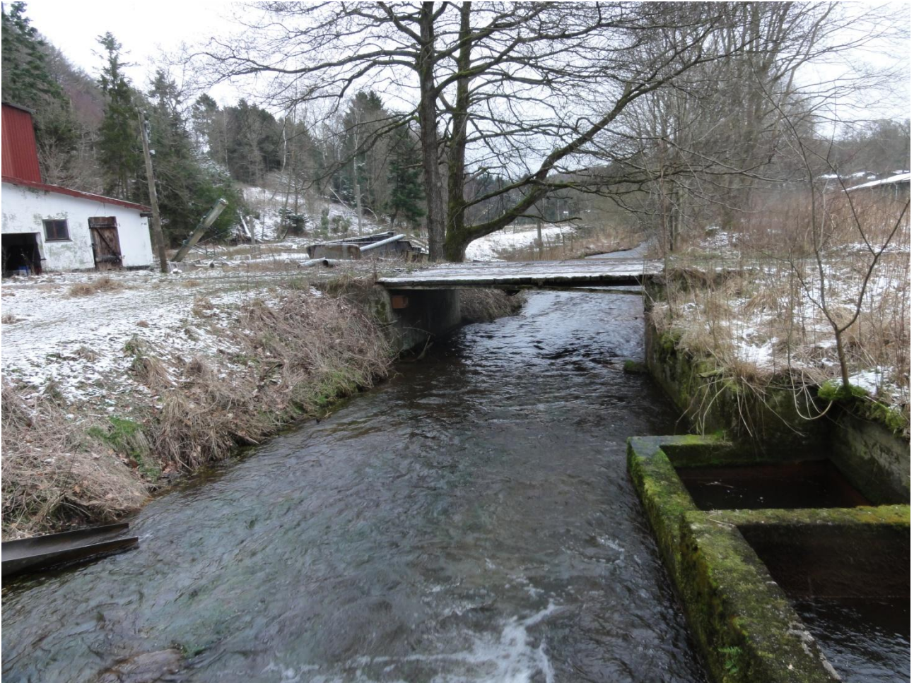
Foto 4 Vejle Å nedstrøms stemmeværket med god fysisk tilstand.
