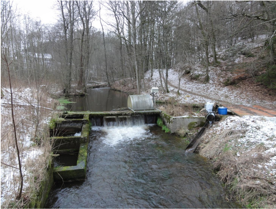
Foto 1 Spærring RIB-00027 der skal fjernes. Billedet viser spærringen som giver opstuvningen opstrøms i Vejle Å. Til venstre i billedet ses fisketrappen.
