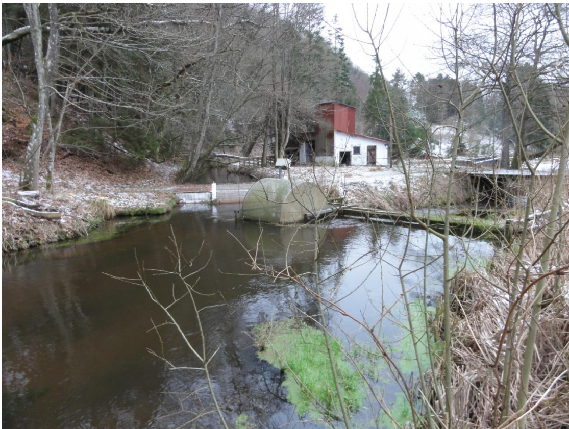
Foto 2 Spærring RIB-00027 der skal fjernes. Billedet viser spærringen og indløbet til dambruget fra opstrøms side.
