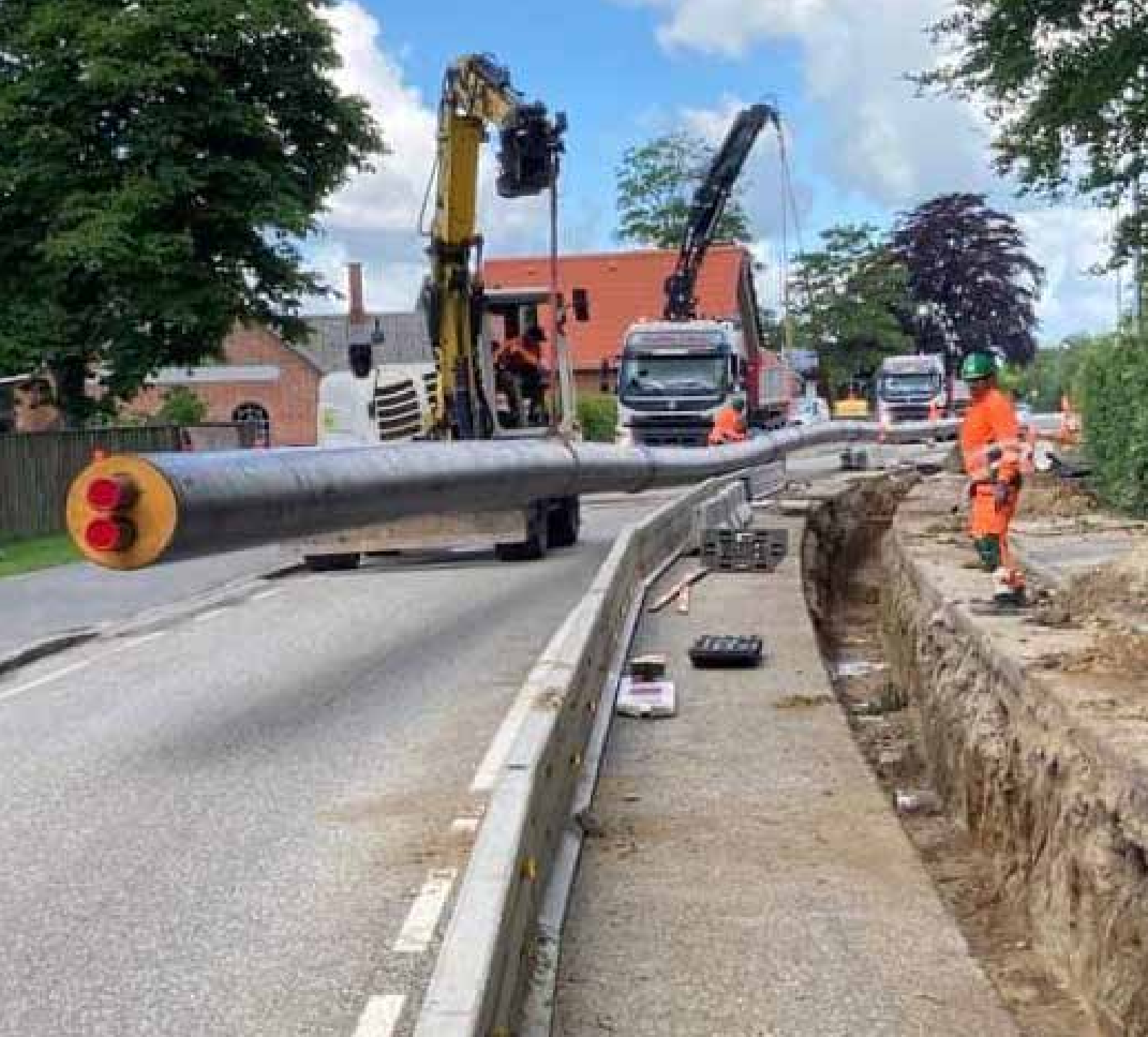
Fjernvarmen rulles ud i Vandel
