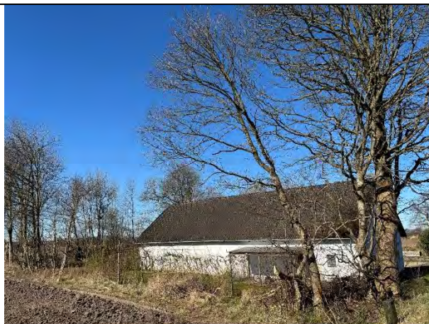
Figur 3. Overbliksbillede - fra den sydlige del af grunden.
