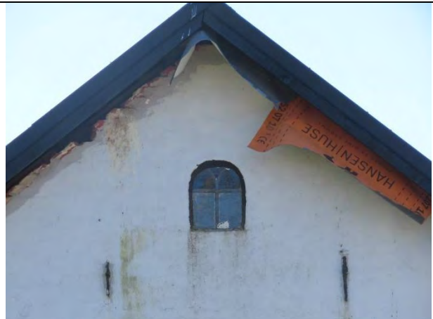
Figur 30. Åbninger i gavl på lade – bygningens nordlige side.
