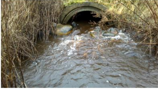
Ved station 1366 - Nedstrøms vejoverkørslen er der lavet en opstuvning gennem røret Vandløbet har en tendens til at gro til i vandplanter mellem station 1400 og 1540 pga. manglende beskygning.
