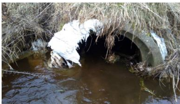
Station 3233 rørunderføring, ind \varnothing 80
