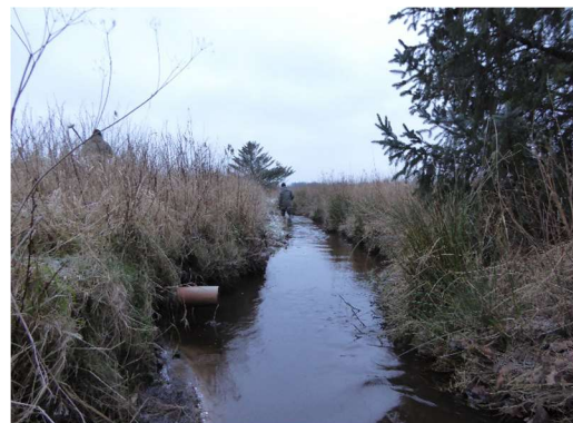
Station 5539. drænudløb 57 cm over bund
