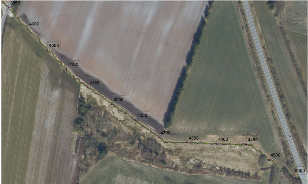
Figur 22 – Luftfoto, forår 2021 – vandløbet er påbegyndt at mæandre
